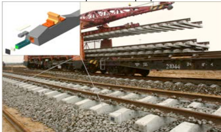
Рисунок 1 – Схема позиционирования контрольных блоков на перегоне
